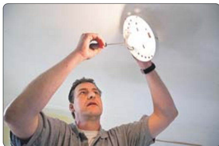
Mit Sorgfalt: Elektromeister Michael Butzkies (45) befestigt eine Lampe in einem Treppenflur. Dank der guten Absprachen haben die anderen Hand-in-Hand-Werker-Betriebe immer rechtzeitig Strom für ihre Maschinen.
