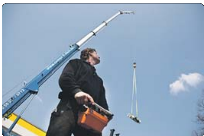
Hoch hinaus: Dirk Hogrefe (42) befördert mit seinem Kran Schweißbahnen zur Dachabdeckung auf eine Fabrikhalle. Der Mit-Geschäftsführer der Zimmerei und Dachdeckerei Compact arbeitet lieber draußen als am Schreibtisch.
